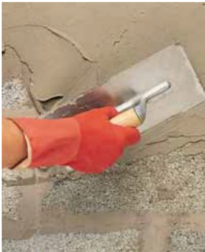
Нанесение Idrosilex Pronto мастерком
