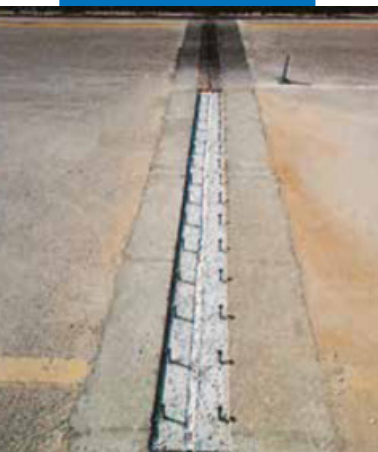
Ремонт пришовной зоны
