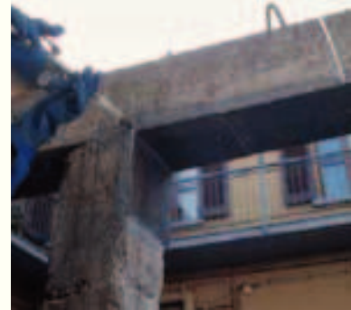
Ремонт балки с инъектирование Epojet
