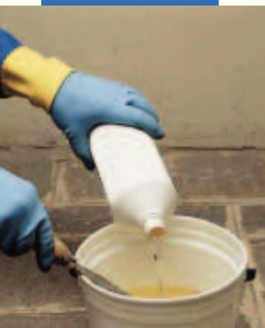
Замешивание Epojet
