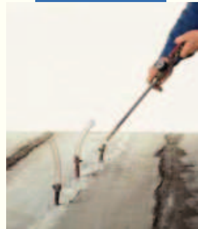
Восстановление горизонтальной конструкции с инъектирование Epojet
