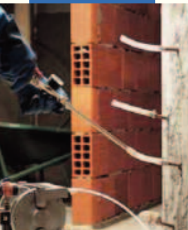
Инъектирование Epojet в трещины колонны
