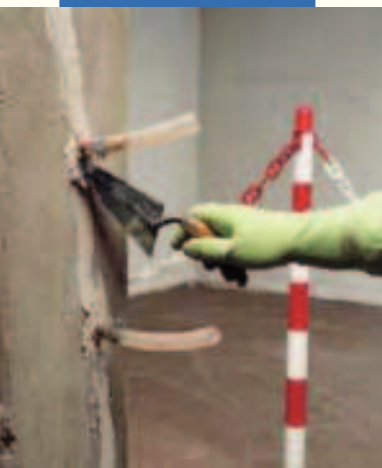
Фиксация инъекционных трубок с помощью Adesilex PG1
