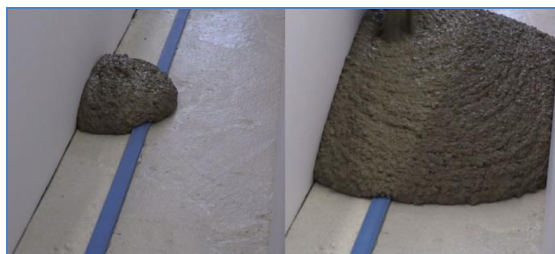
При монтаже на герметик бетонирование не ранее чем через 8 часов.
