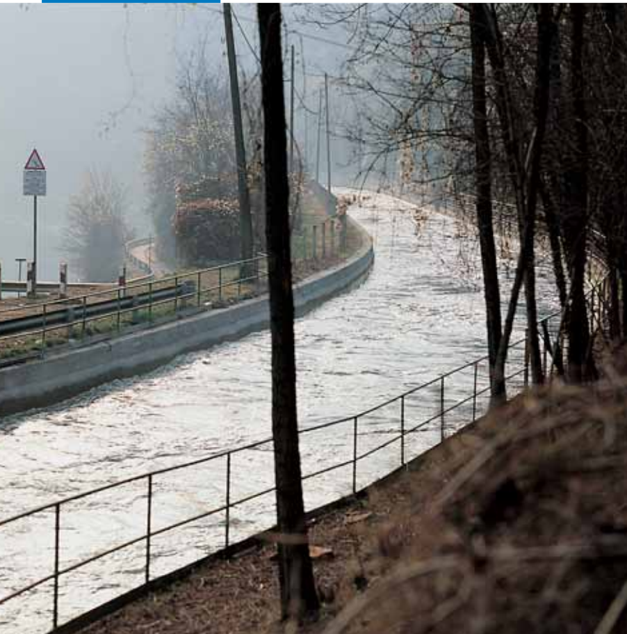
Подводящий канал ГЭС в г. Бертини – Робьяте (Область Комо) с поверхностью, обработанной Idrosilex Pronto
