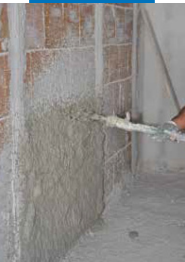
Нанесение Intomap 340 набрызгом
