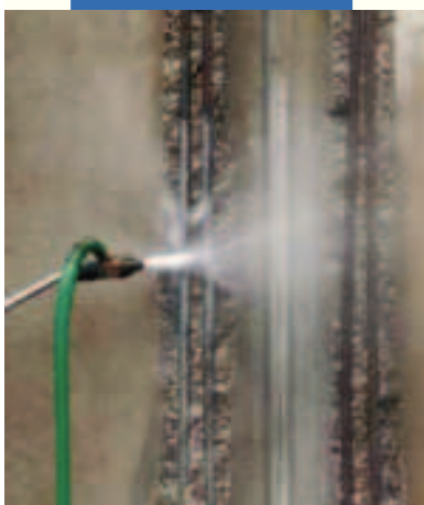
Очистка стальной арматуры
