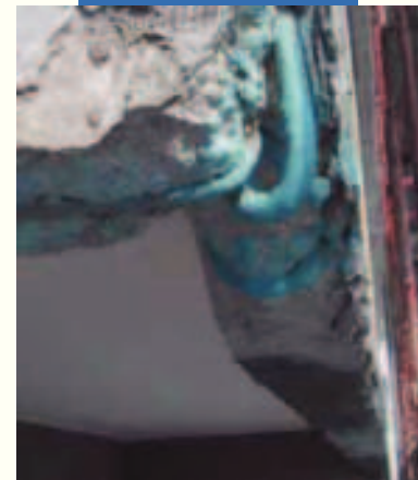
Арматура на балконе, обработанная Mapefer 1K
