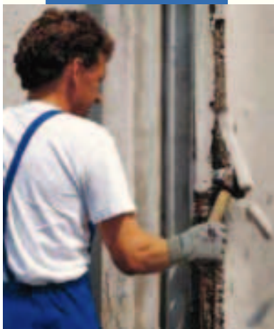
Удаление поврежденного бетона
