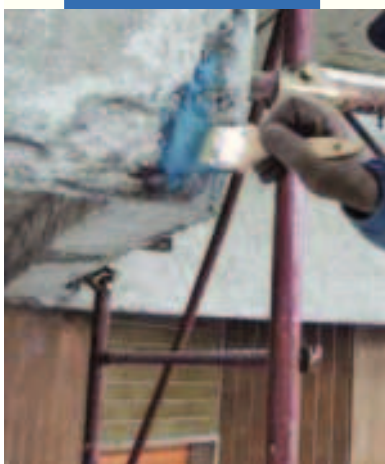
Нанесение Mapofer 1K кистью на арматуру балкона
