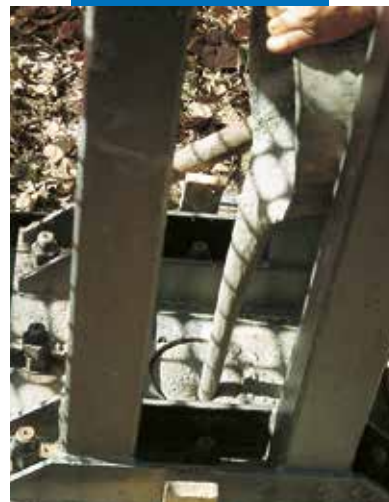
Анкерное крепление с помощью раствора Mapefill
