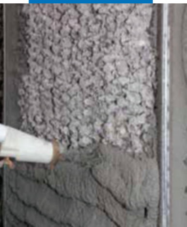
Нанесение Марегрут 230 набрызгом
