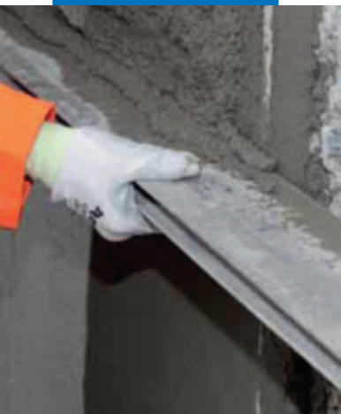
Выравнивание Марегрут 230 при помощи правила
