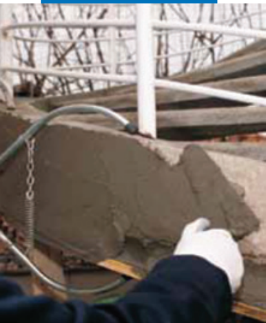
Нанесение Марегрут 230 при помощи мастерка
