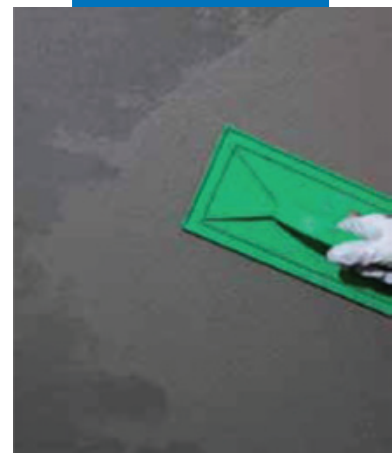
Трамбовка Mapegrout 230
