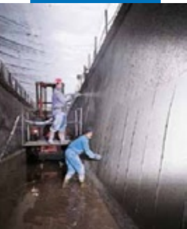
Канал гидроэлектростанции в г. Бертини-Робьяте (Область Комо): отделка мастерком
