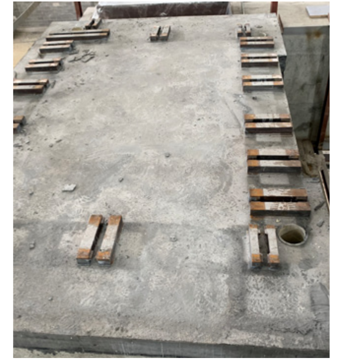
Подливка фундамента турбин, комплексов оборудования и металлоконструкций материалами MAPEI
