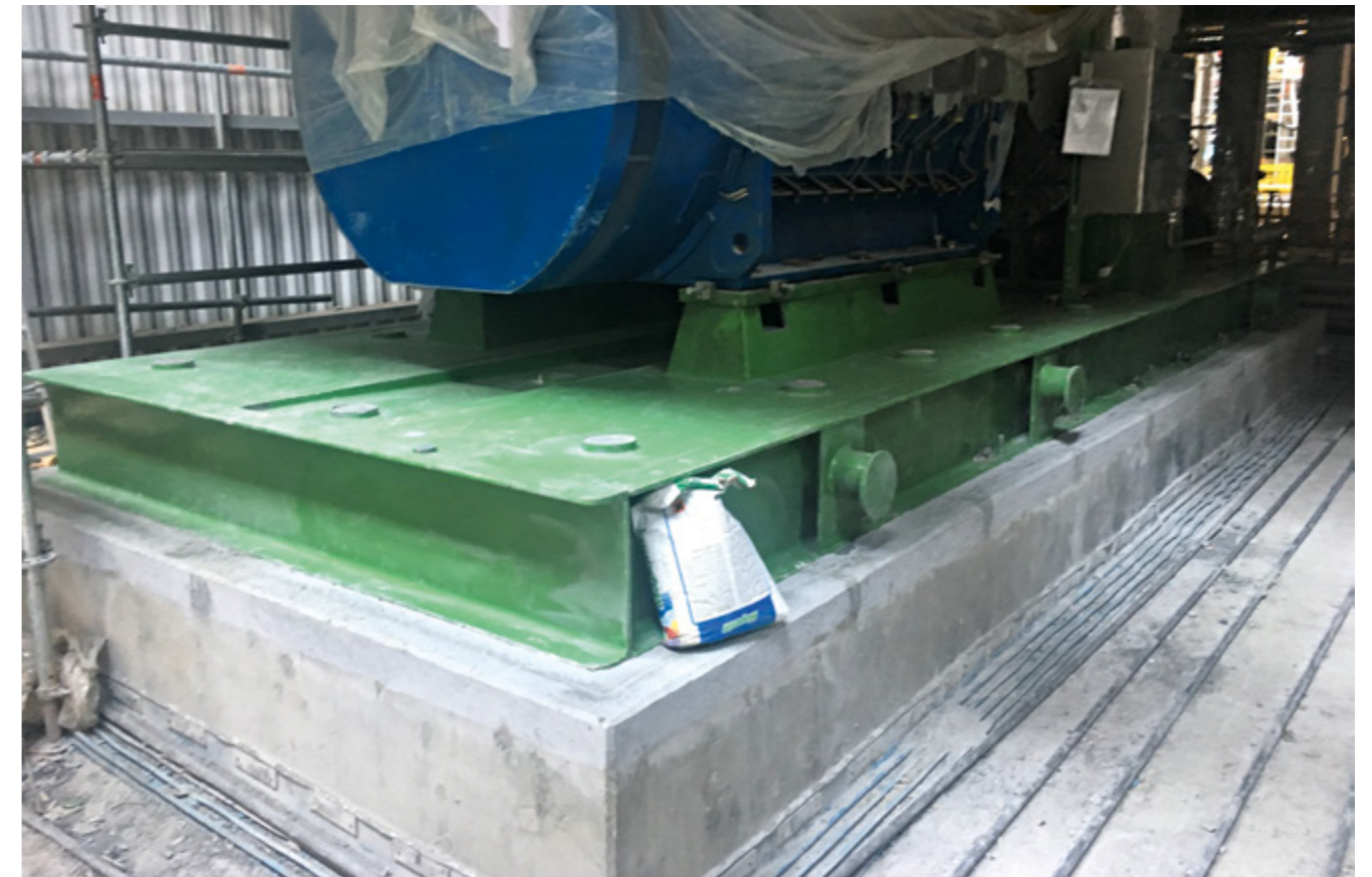
Подливка фундамента турбин, комплексов оборудования и металлоконструкций материалами MAPEI
