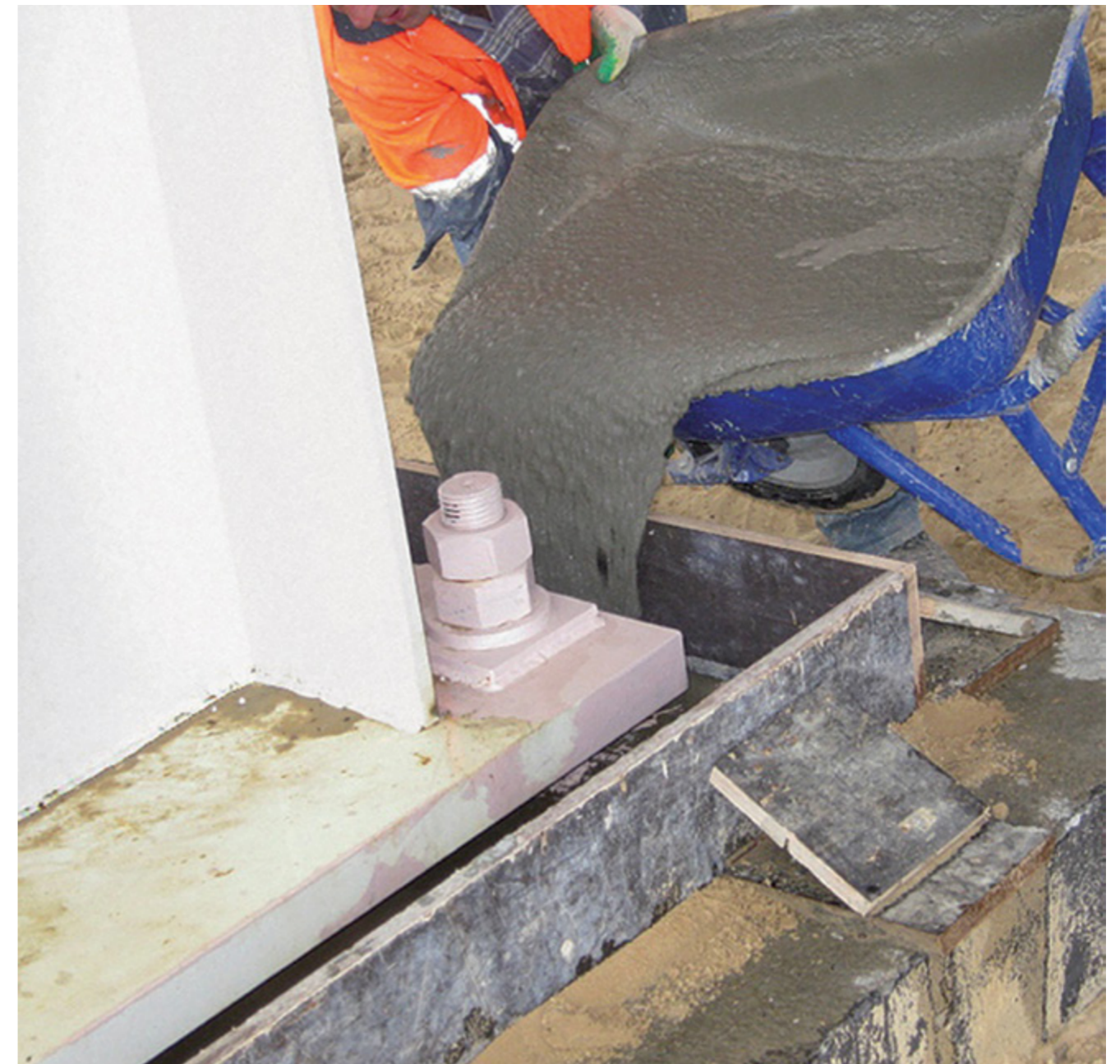
Решение 5. Подливка фундаментных болтов в анкерных колодцах
