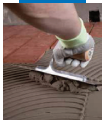
Нанесение Granirapid на гидроизоляцию Mapelastic на террасе
