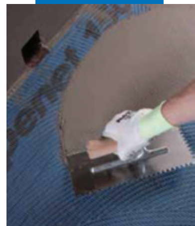
Нанесение Mapelastic на Marenet 150
