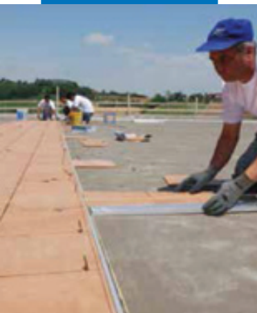
Укладка керамической плитки с применением Kerabond + Isolastic
