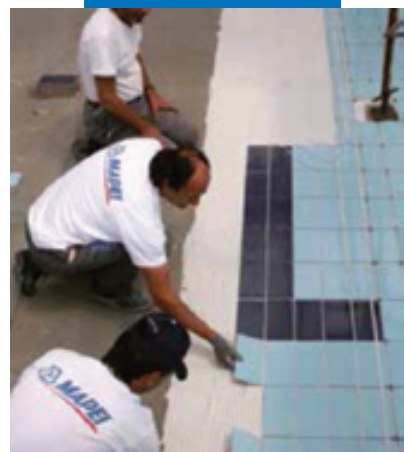
Укладка керамической плитки на Mapelastic в бассейне
