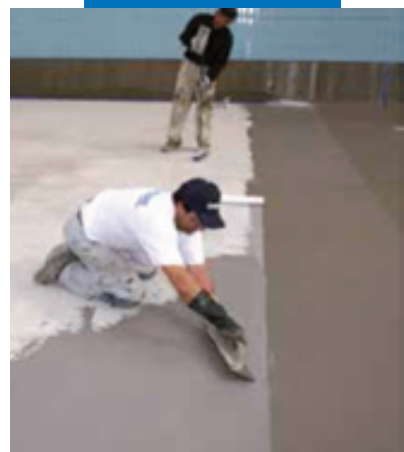
Гидроизоляция бассейна с применением Mapelastic
