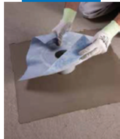
Установка вертикального дренажа на Mapelastic
