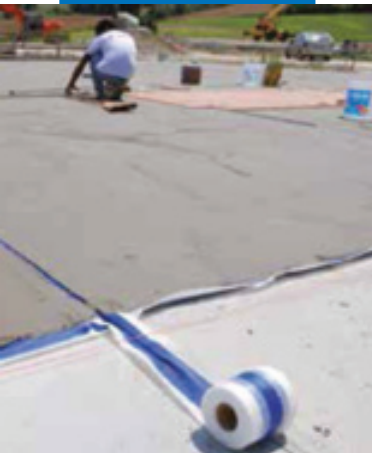
Гидроизоляция стяжки с применением Mapelastic и Mapeband
