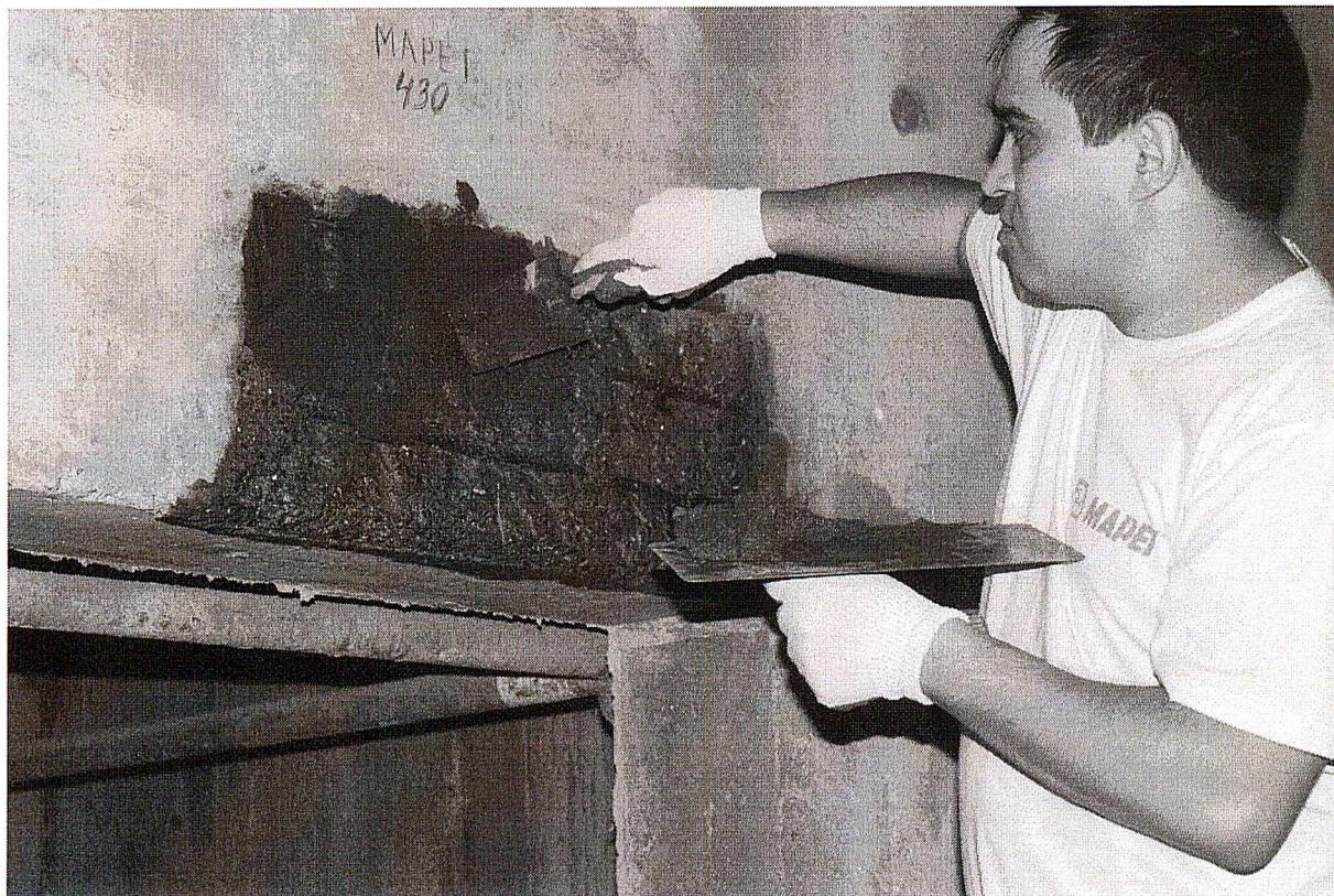
8.2. Для увеличения толщины наносимого ремонтного состава наносятся дополнительные слоя ремонтного состава максимальной рекомендованной толщиной. Время выдержки перед нанесением последующего слоя **Mapegrout Thixotropic**, **Mapegrout T40**, **Mapegrout 430** составляет 3-4 часов (при температуре +20<sup>0</sup>C), перед нанесением последующего слоя **Mapegrout Fast-Set R4** составляет 20-30 минут (при температуре +20<sup>0</sup>C)
