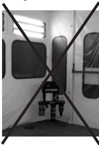
usage non conforme
